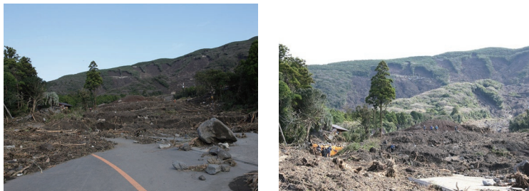
2013年 台風第26号による伊豆大島の土砂災害
