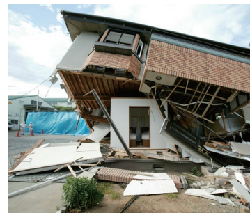
耐震シェルターが設置された木造住宅が地震により倒壊した場合
